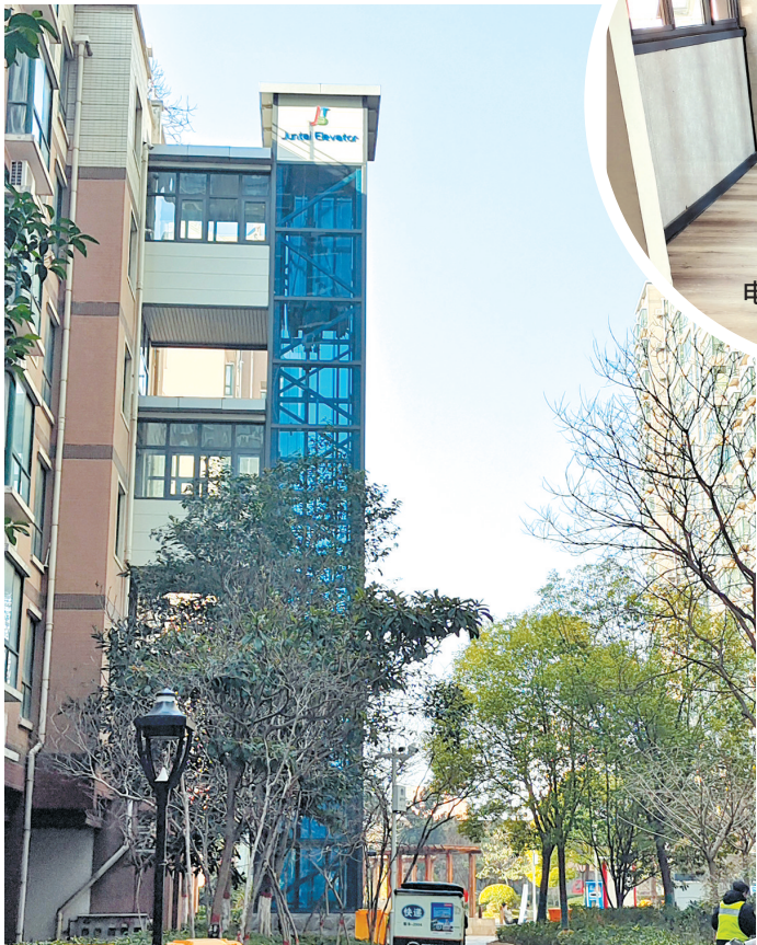
裕华第九城市6号楼的既有住宅加装电梯已投入使用
