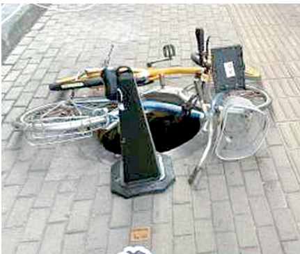
用车子遮挡没井盖的窨井口
