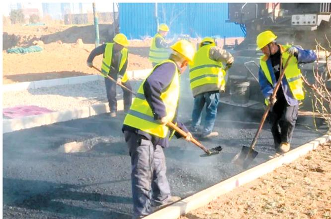
设完毕。施工人员将充分利用晴好天气,加快施工进度,完成整条道路的底层沥青铺设和部分道路面层沥青
