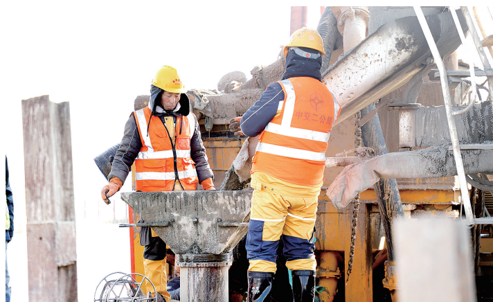
桩基浇筑现场
