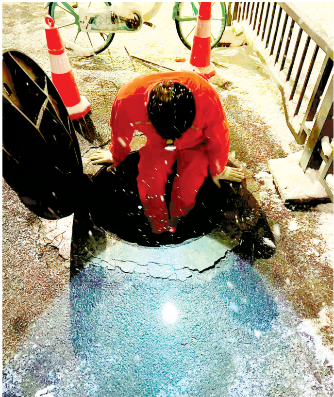
热力管网运维人员冒雪作业
