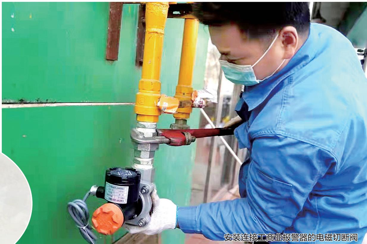
安装连接工商业报警器的电磁切断阀
