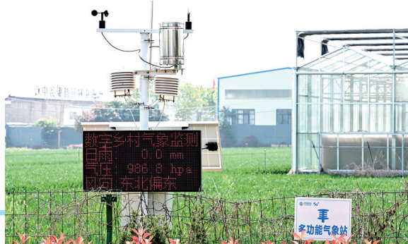
在南屯村建设的多功能气象站
