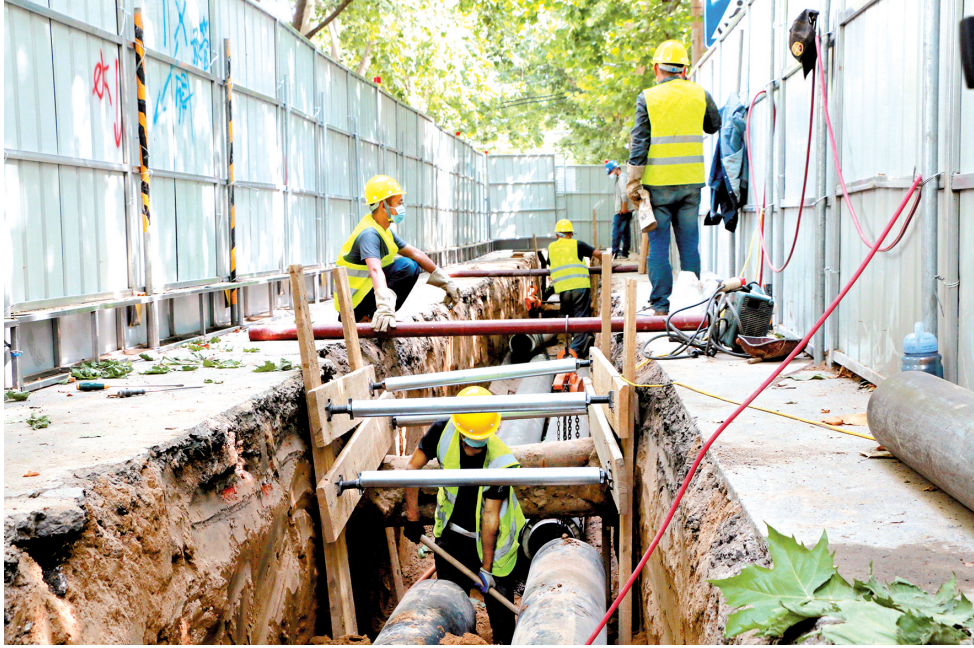
工人正冒着高温,对老旧供热管网进行改造施工
