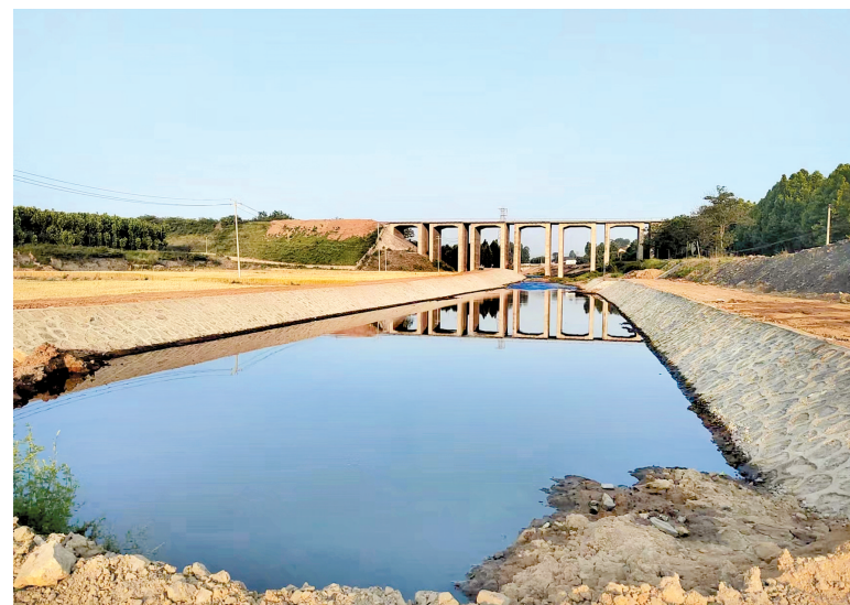
176处水毁水利工程修复重建项目已基本完成
