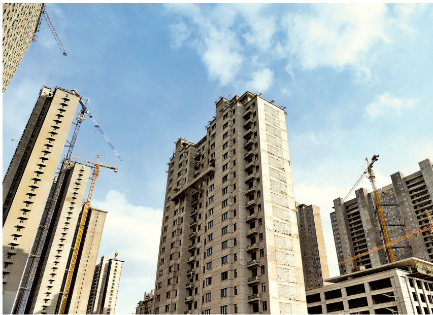
房地产项目工地正在抢抓施工的黄金季节 新华社发
