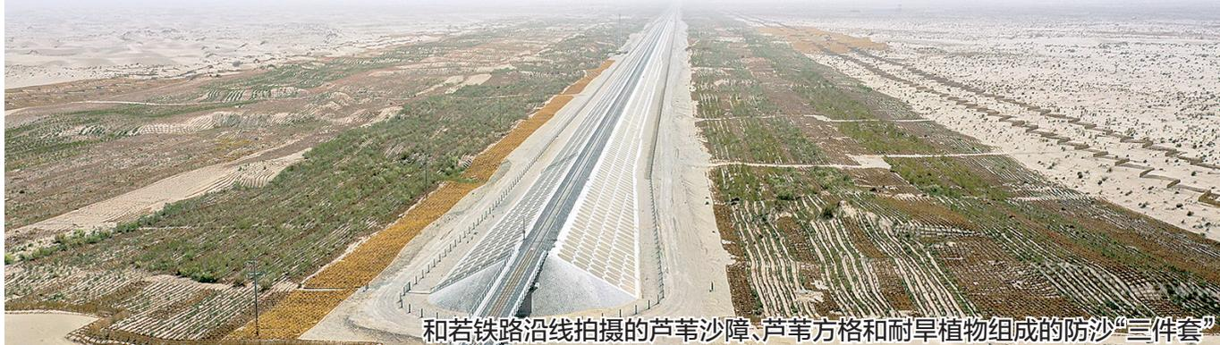
和若铁路沿线拍摄的芦苇沙障、芦苇方格和耐旱植物组成的防沙“三件套”
