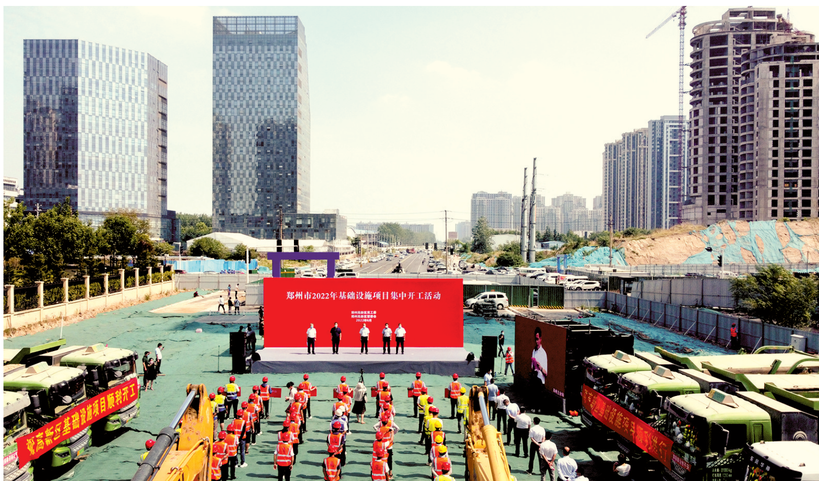
本报讯 6月21日,郑州高新区基础设施项目集中开工仪式在垂柳路道路及排水工程现场举行,高新区16个基础设施新建项目集中开工,总投资22.5亿元。此举将进一步推动城市功能的完善提升,为高新区“两区四高地”建设蓄势增能。记者 孙庆辉 高新时报 方宝岭 文/图
