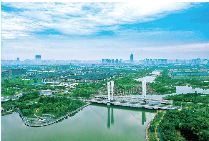
北三环跨西运河桥
