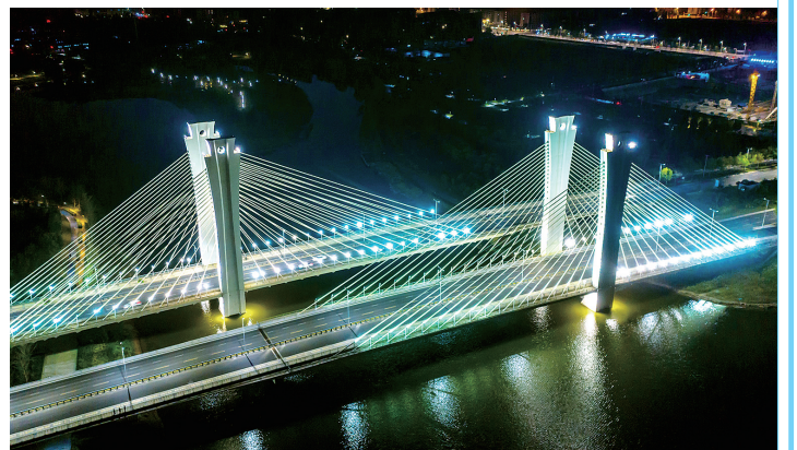
北三环跨东运河桥
