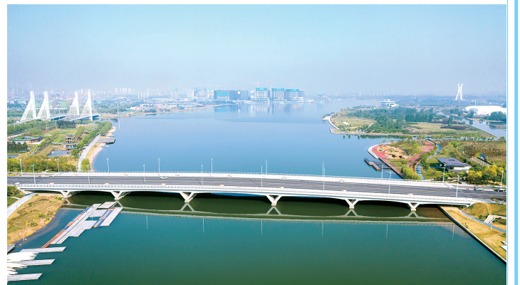
龙湖内环路跨龙尾河桥
