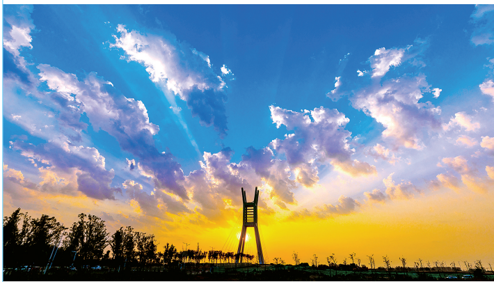
龙湖内环路跨北引水渠桥
