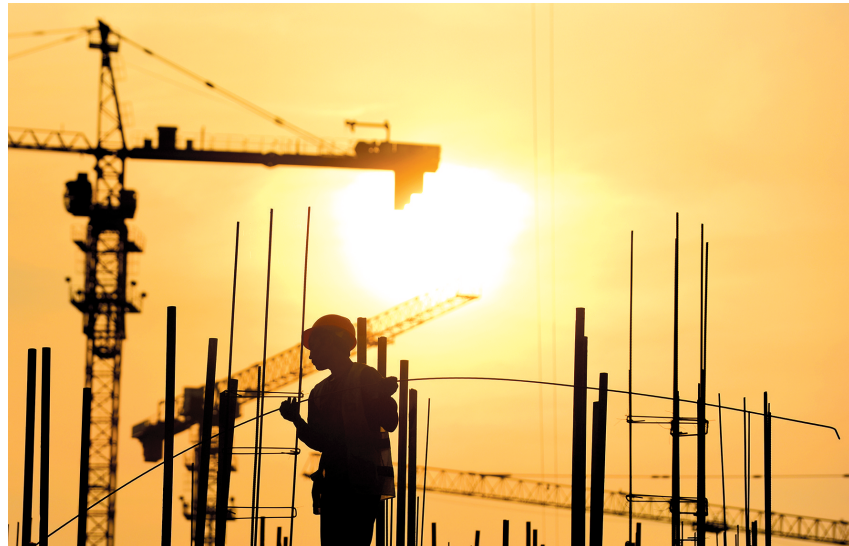
工人在江苏无锡一处住宅小区施工 新华社发
