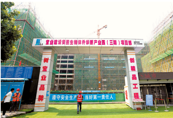
安图生物三期正在紧锣密鼓地施工
