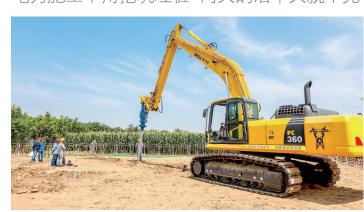
本报讯(正观新闻·郑州晚报记者 张华 通讯员韩彦 罗浩 文/图)8月24日,新郑郭店镇附近的220千伏枣园变输电工程施工现场,一台庞大的工程机械像电动螺丝刀一样轻松地将一根近10米的螺旋锚"钉"进了地下。整个过程不到10分钟。
