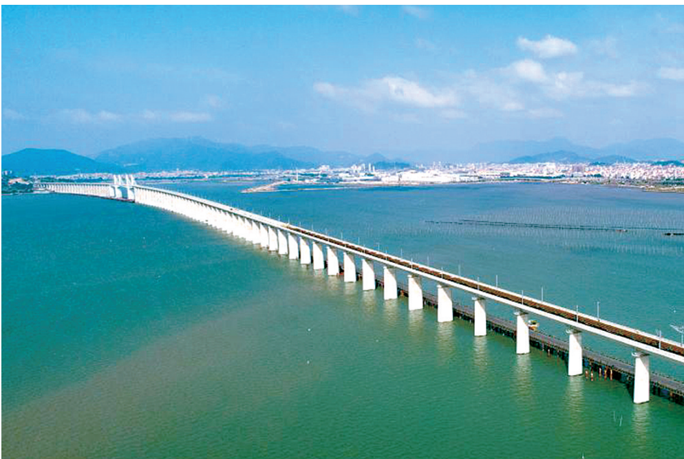
4月15日拍摄的建设中的新建福厦铁路湄洲湾跨海大桥 新华社发
