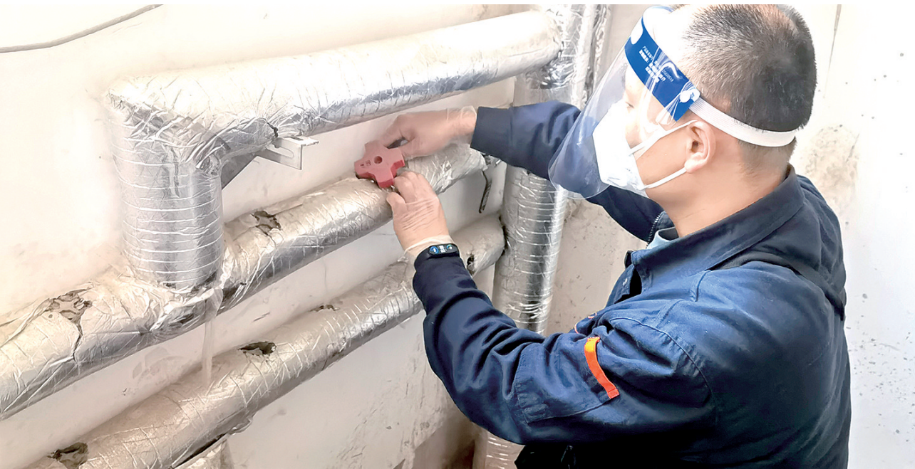
热力工作人员在居民小区检查供暖设施
