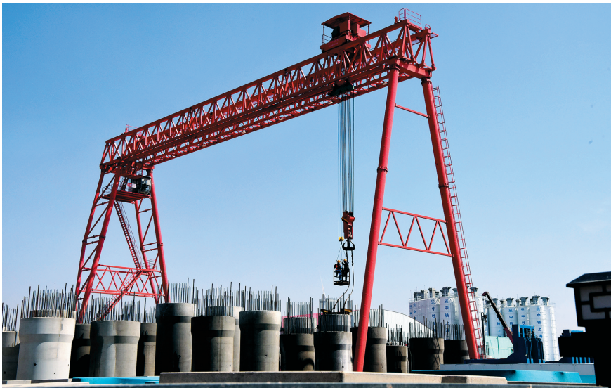
6月14日,郑济高铁濮阳至省界标段装配式桥梁墩柱预制现场 新华社发
