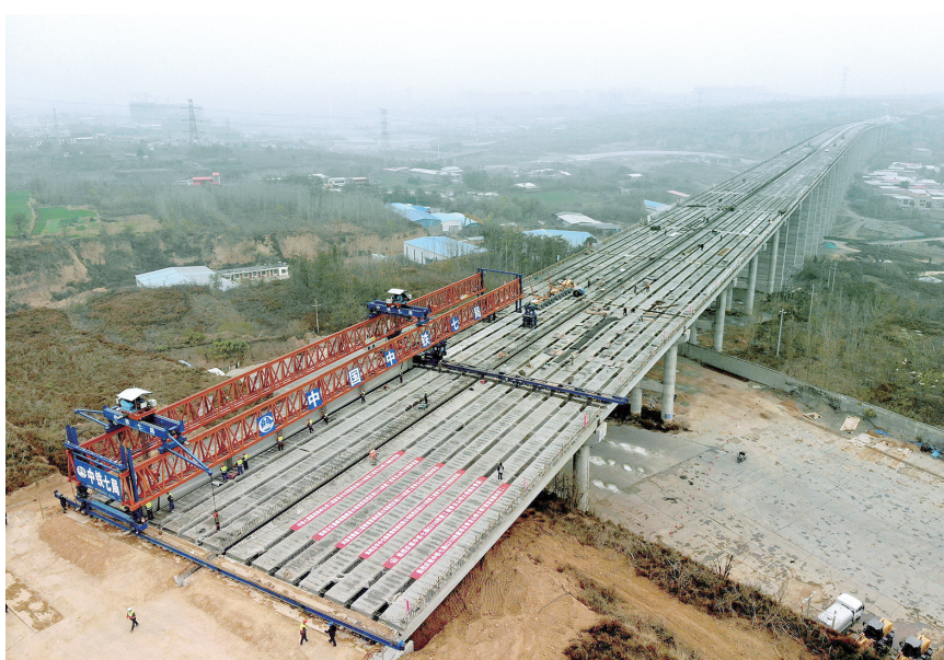
青龙山特大桥架梁施工现场
