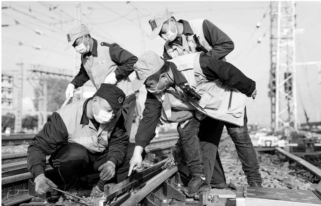
本报讯(正观新闻·郑州晚报记者 张倩 通讯员 李中华 文/图)全面夯实线路基础,保障枢纽安全畅通。昨日,中国铁路郑州局集团有限公司郑州桥工段组织45名干部职工配合2台大型养路机械,对郑州北站下到场4组道岔进行捣固和综合整治作业。
