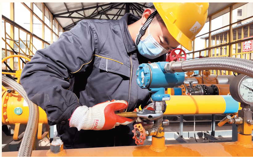
牛师傅党员先锋队队员检修燃气设备
