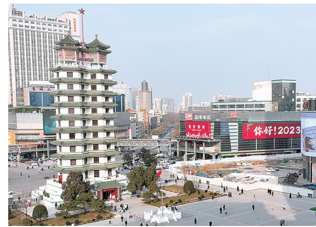
二七广场隧道工程地面主体已经完工
