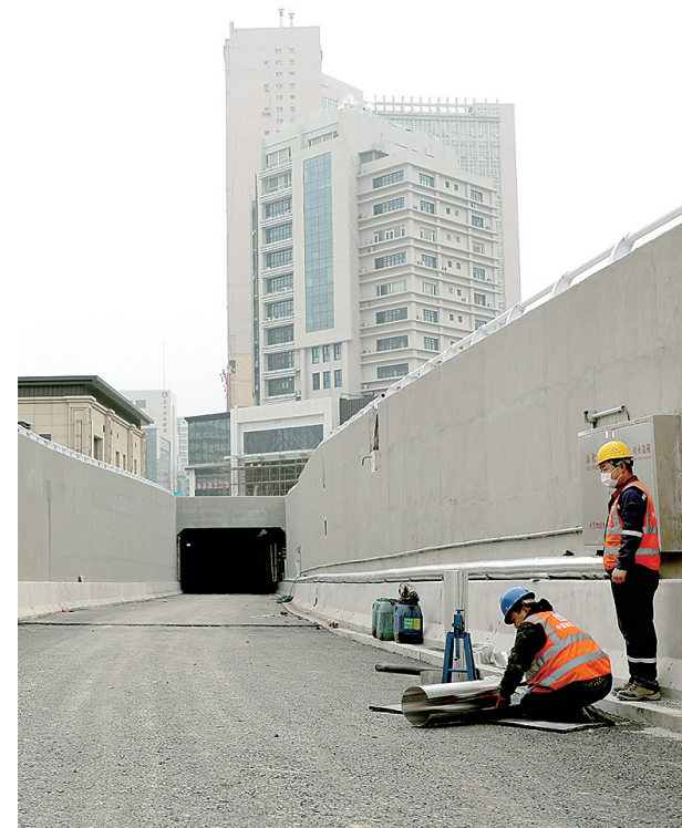
隧道匝道口墙面施工
