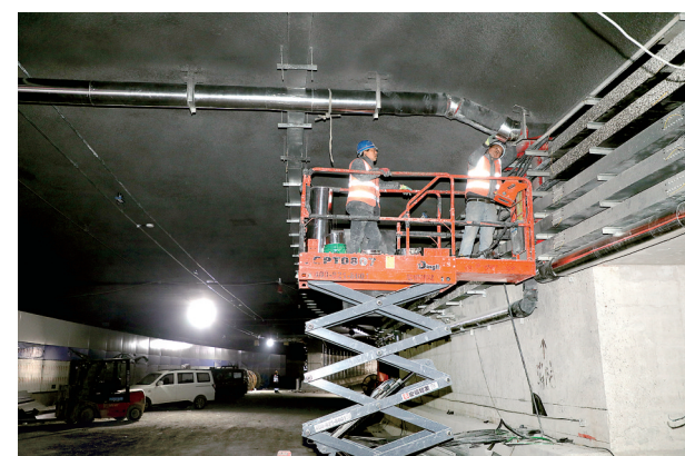
隧道内消防管道施工
