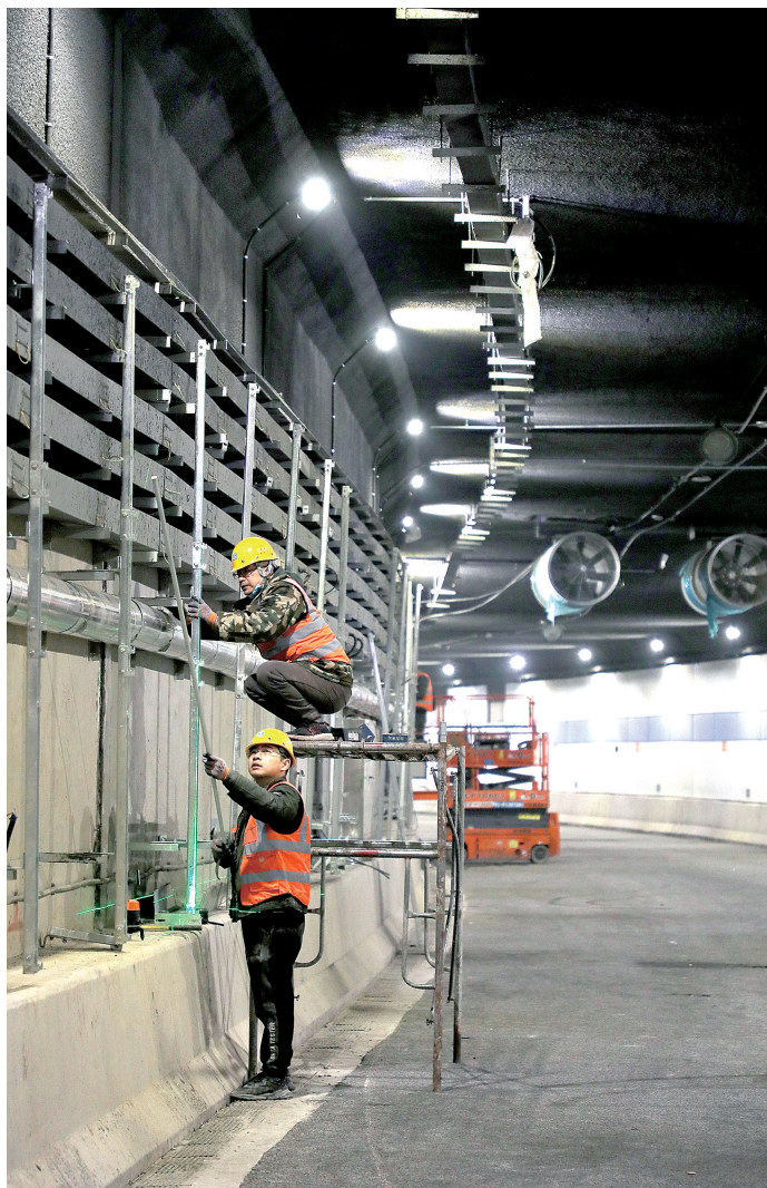
隧道内饰面施工作业
