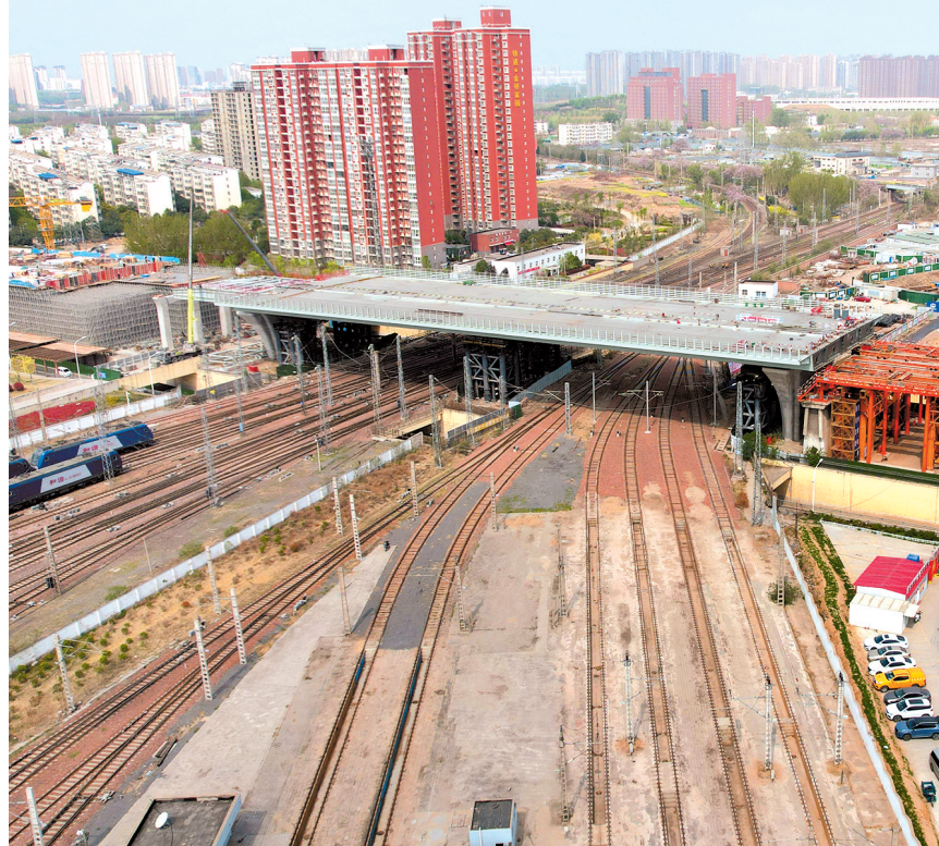
彩虹桥主桥钢箱梁顶推施工已全部顺利完成
