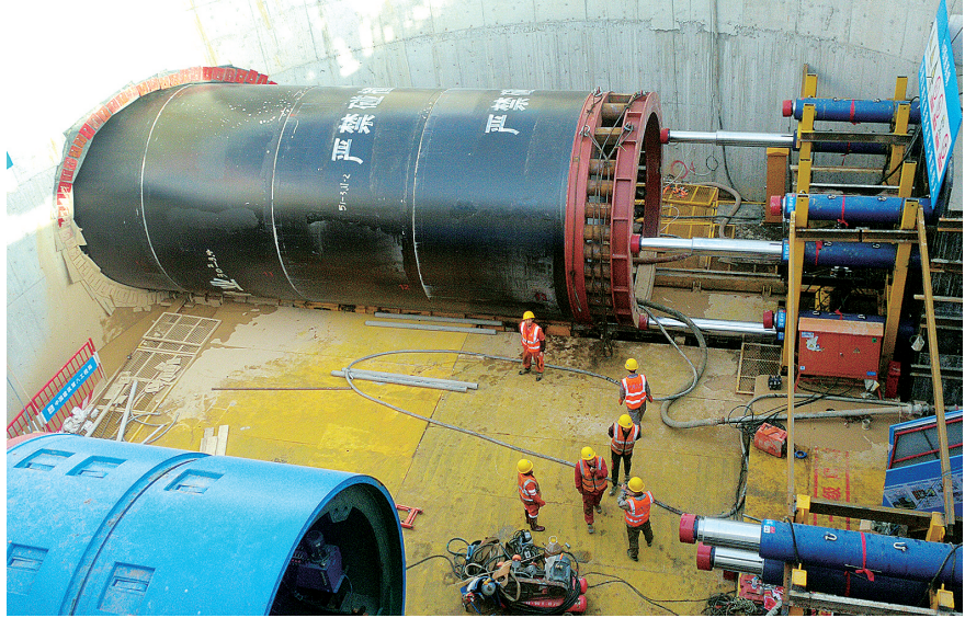
金水河分洪工程3号沉井施工现场
