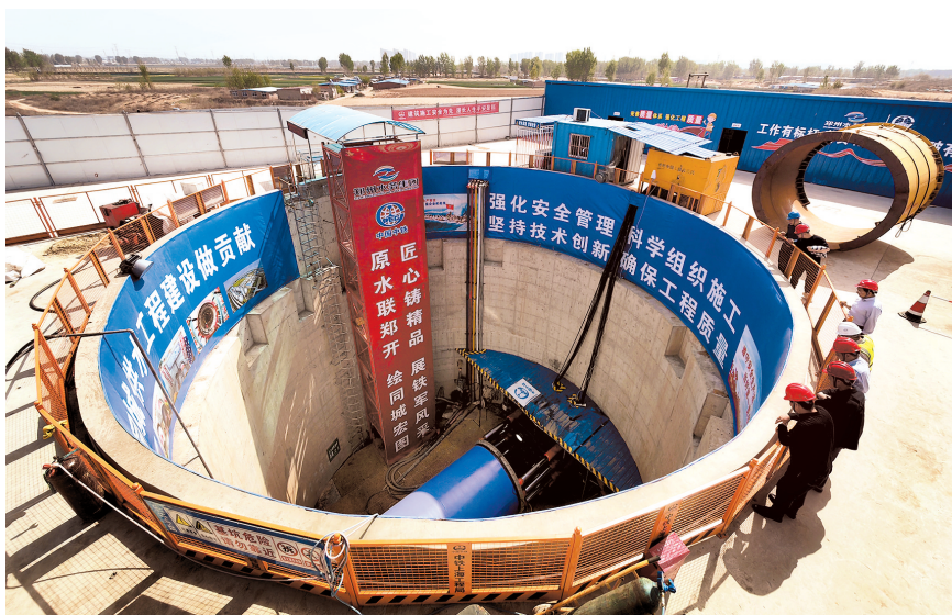
郑开同城郑州东部原水干管工程首段贯通仪式现场
