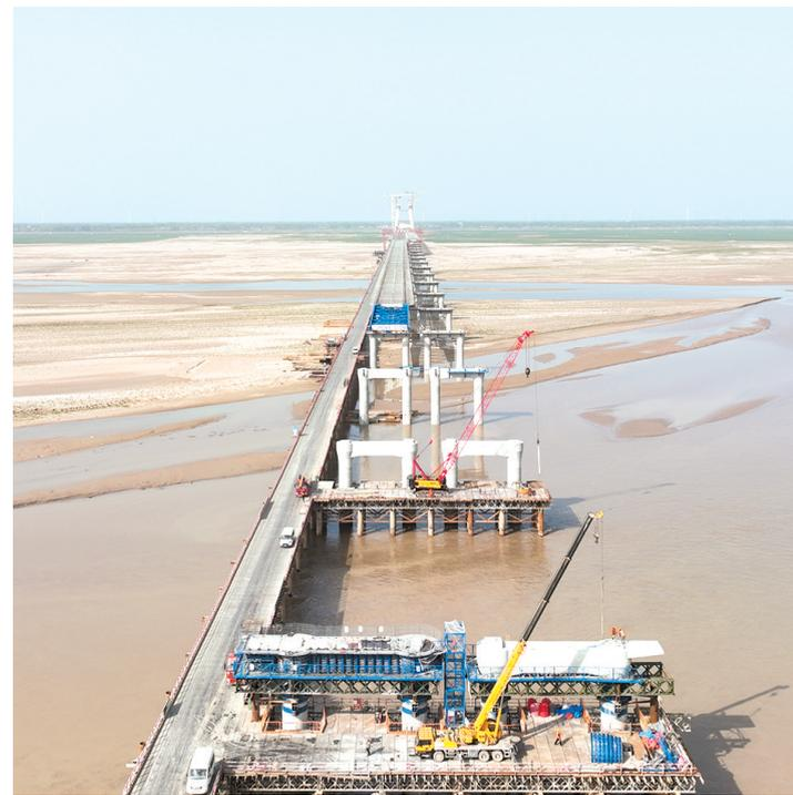
4月6日,随着最后一车混凝土缓缓注入,黄河特大桥南幅桥最后一座系梁顺利浇筑完成,标志着中交二公局黄河高速YZSG-2标率先全部完成标段内下构施工,项目将全面转入上部施工。
