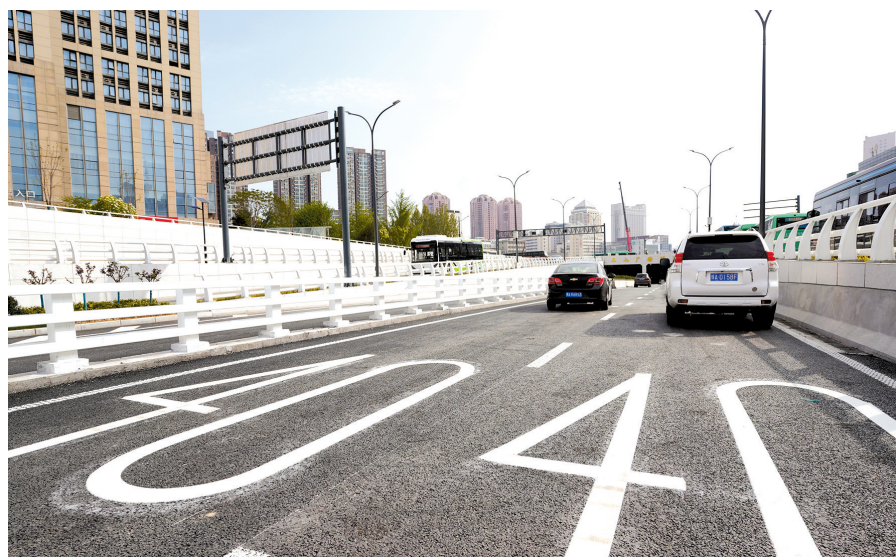
二七广场隧道主线西出入口
