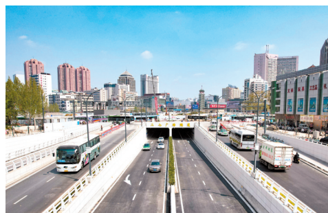
二七广场隧道主线西出入口
