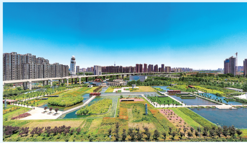
南三环中水公园的下方是水务公司污水处理厂,地上顶层是一所公园,面向市民开放
