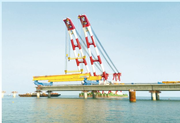
世界最大吨位——科威特1800吨架桥机
