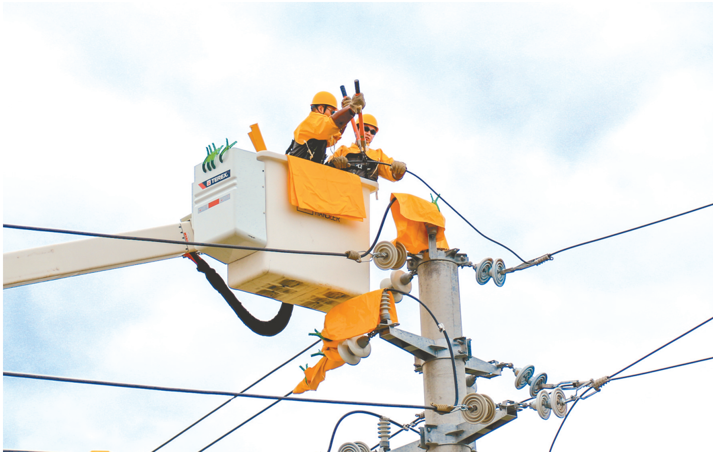
冒着高温,带电作业为用户接入新线路
