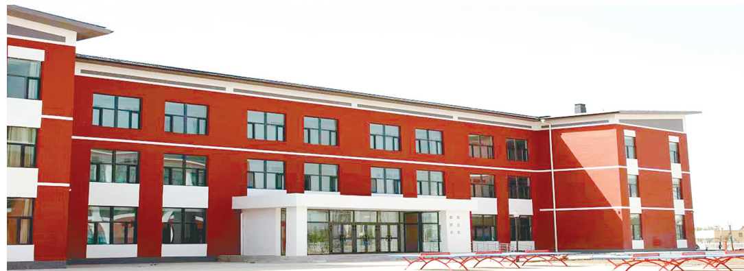
哈密高新区河南援疆产业园标准化厂房及配套工程效果图
