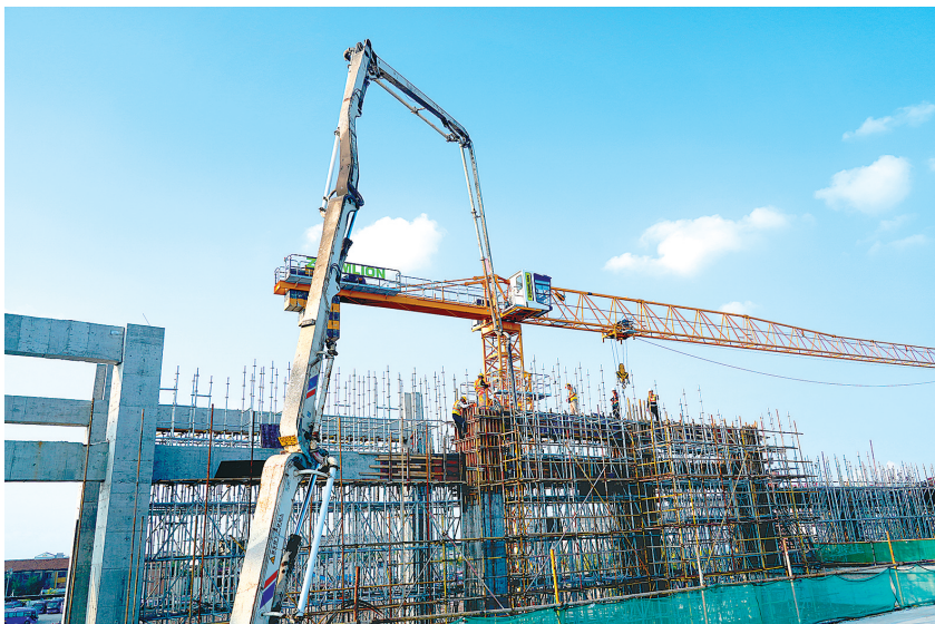
开封站侧式站房施工现场
