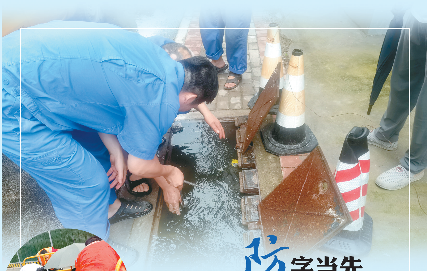
棉纺路街道 井盖破损存隐患 及时处理保民安
