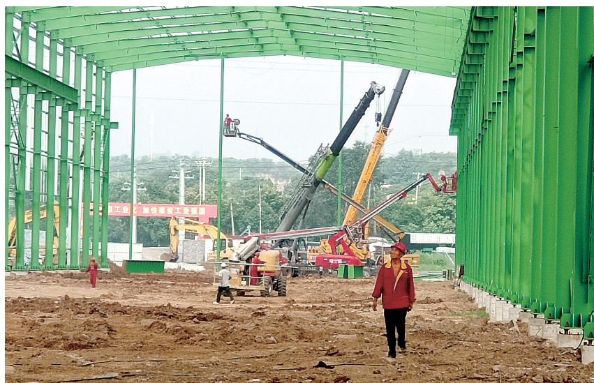
正在建设的园区钢结构厂房
