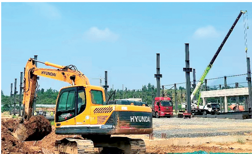
三一智能制造产业园项目施工现场
