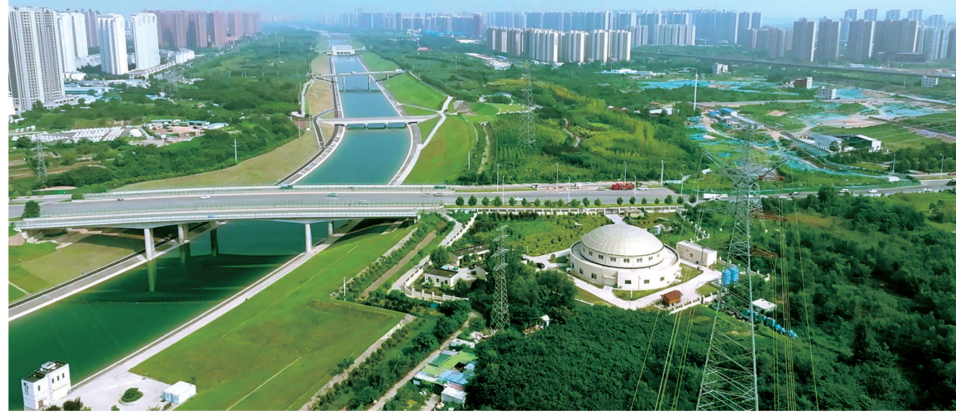
郑州南部片区守着南水北调干渠
