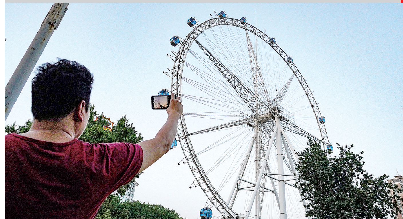
一市民拿手机拍摄拆除中的摩天轮。昨日傍晚,摩天轮已经拆除了大概60%的中篮
