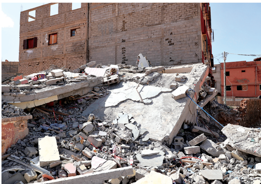
摩洛哥震中附近的艾米兹米兹村拍摄的损毁建筑 新华社发
