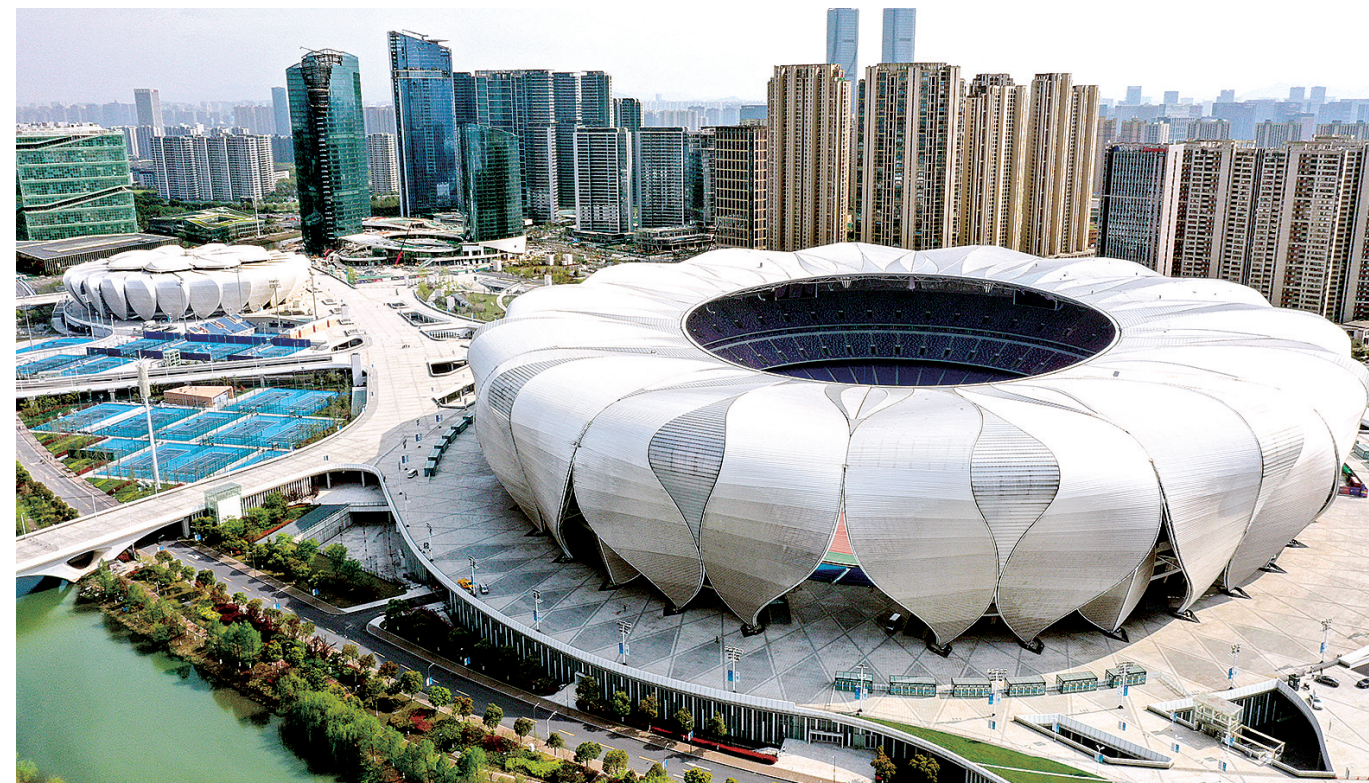
杭州奥体中心体育场(右)和杭州奥体中心网球中心静待亚运会开幕 新华社发
