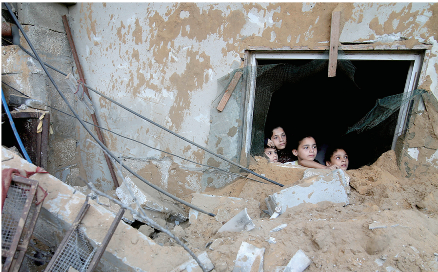
10月15日,在加沙南部城市拉法,儿童在遭以空袭后的建筑中张望 新华社发
