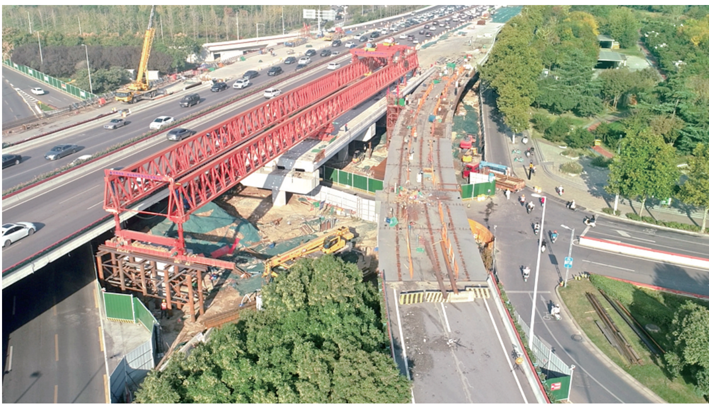
中州大道金水路立交东向北匝道加紧施工
