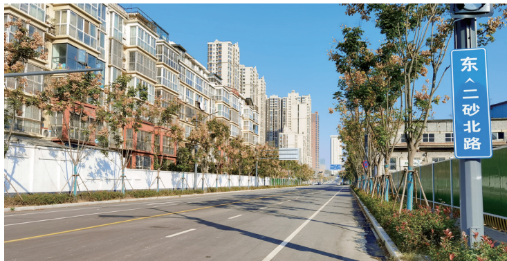
二砂北路已铺设完毕等待开通
