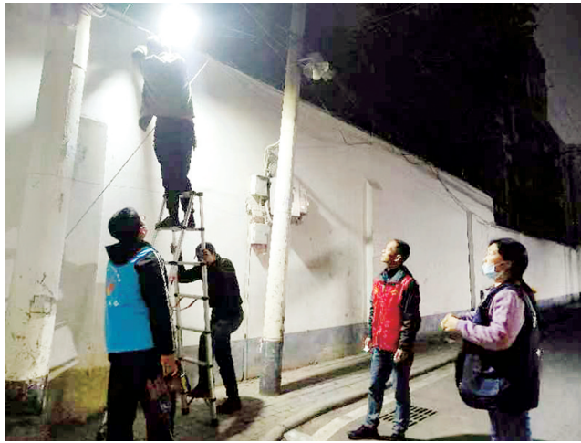
正在安装路灯
