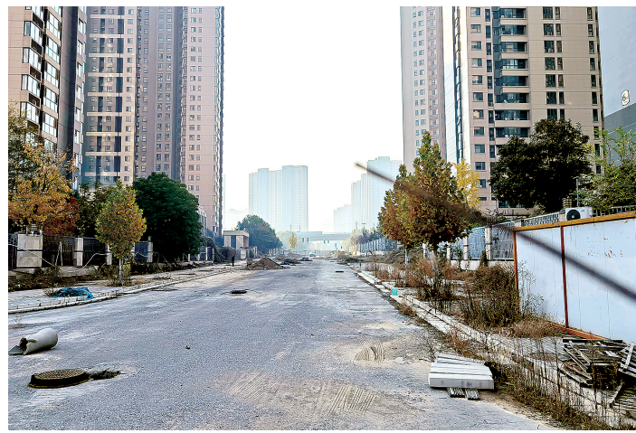
建了3年没有完工的渣呀山路
