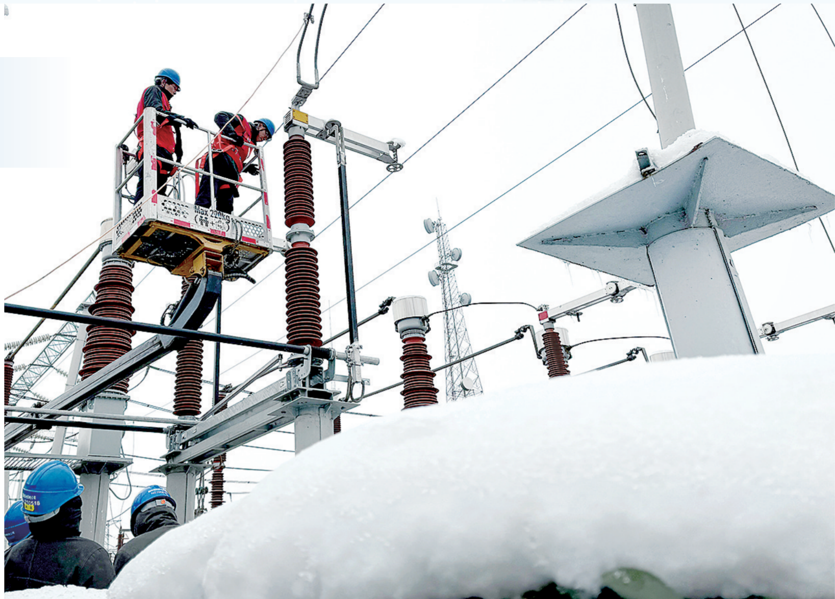
国网郑州供电公司在上街开展直流融冰工作
