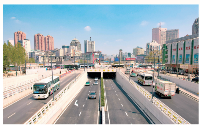
2023年3月31日,二七广场隧道正式通车,中原路地下通道向东延伸到西大街 记者 马健 图
