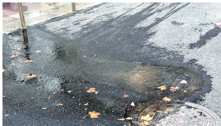
污水井流出的污水已结冰
