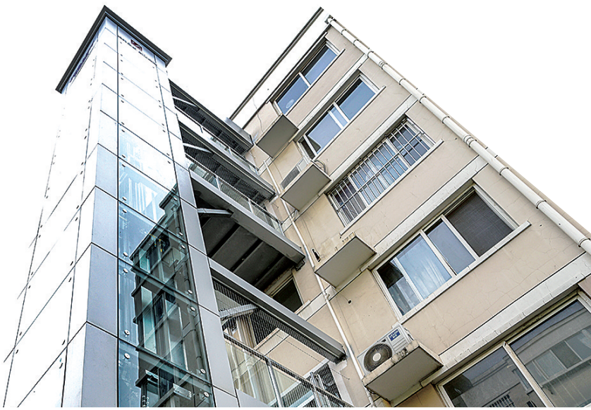
管城区一老旧小区内加装了电梯
