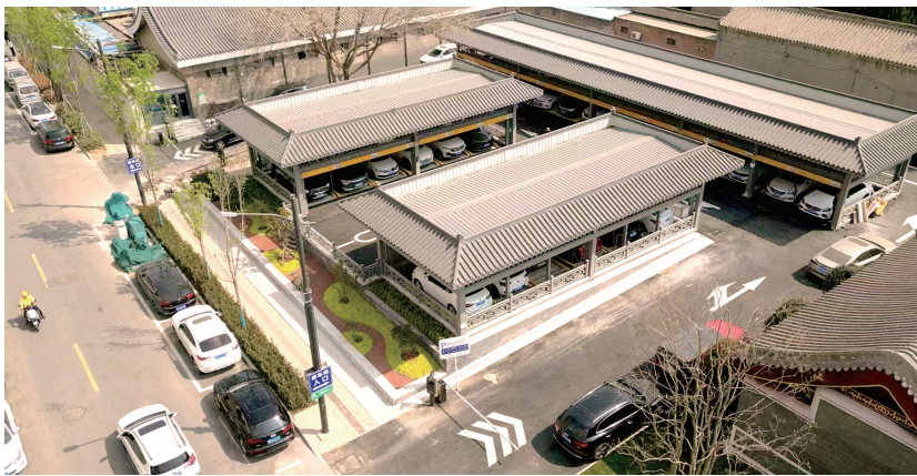
商城路的立体停车场
