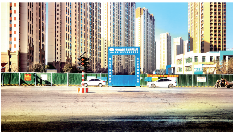
站马屯路围挡仍未拆除
